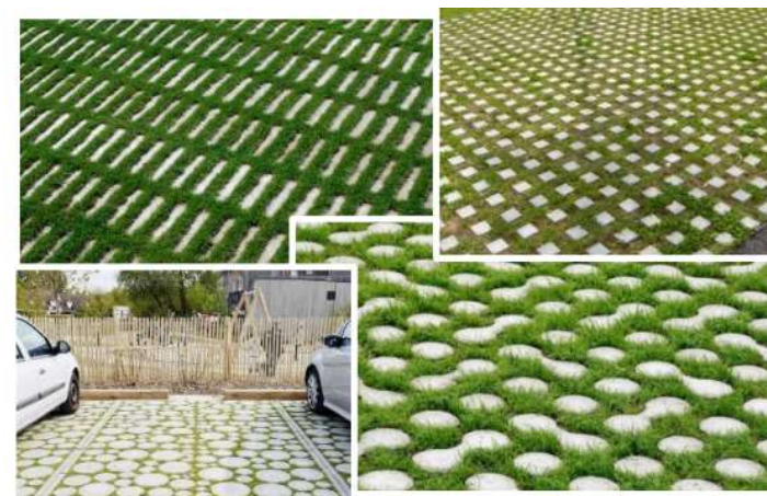
Stationnement en pavés gazon drainants
