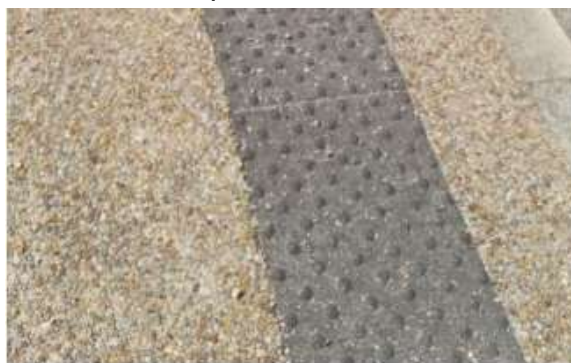
Dalles pododactiles béton aux traversées piétonnes
