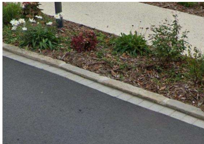
Chaussée en enrobé et bordure granit de récupération
