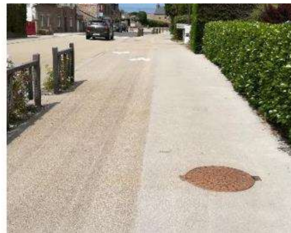
Enrobé hydro-décapé sur accotement piétons/cycles
