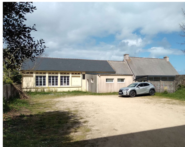
Vue de la salle communale en fond de parcelle
