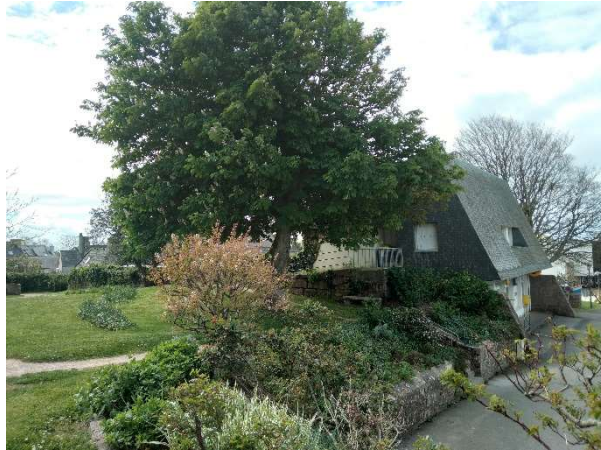
Vue depuis le parvis Ouest de l'Eglise
